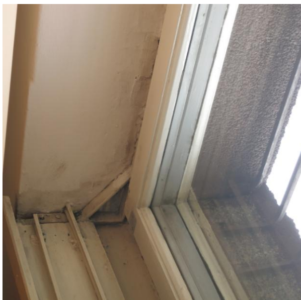
Slika 1.2.a. Prozori „krilo na krilo“, dvostruko ostakljenje, drveni okviri
