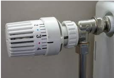
Slika 2.4. Termostatski ventil
