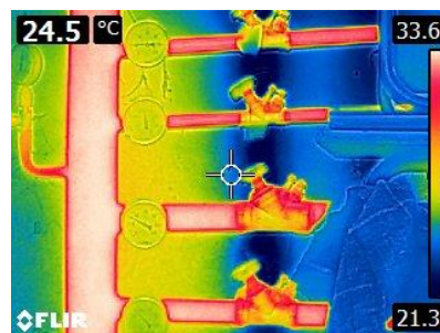
Slika 5. Termografski snimak dijelova unutrašnje instalacije sistema grijanja
