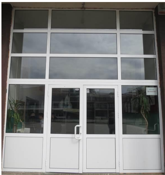
Slika 1.2.c Ulazni portal na jugoistočnoj strani Objekta
