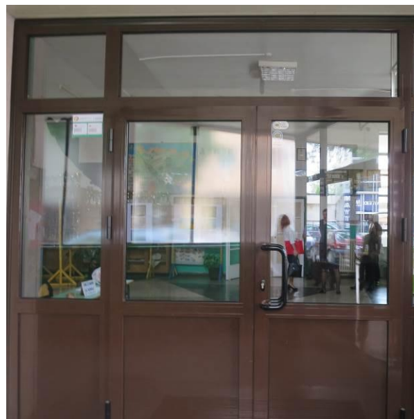
Slika 1.2.d Ulazni portal na jugozapadnoj strani Objekta
